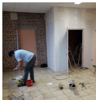
Isolation de la petite salle et confection d'un rangement
